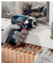
Montaje de ventanas
